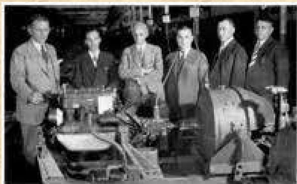
Model A Ford enjin op die dinamometer in 1927
